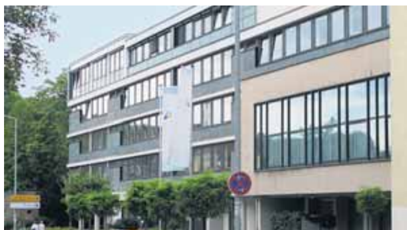
Neuer Glanz: Die Aufstockung ist fertig. Das Gerüst am Nebengebäude der Kreisverwaltung ist verschwunden. TV-FOTO: FALK STRAUB
